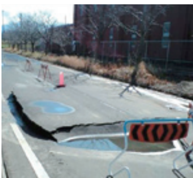
基幹的な用水管の沈下(霞用水)
