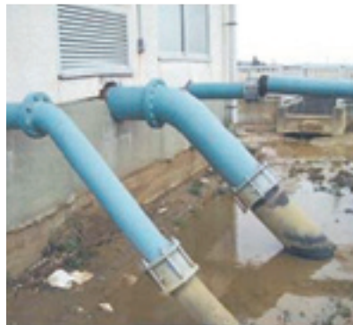
用排水機場敷地の沈下(鉾田市)
