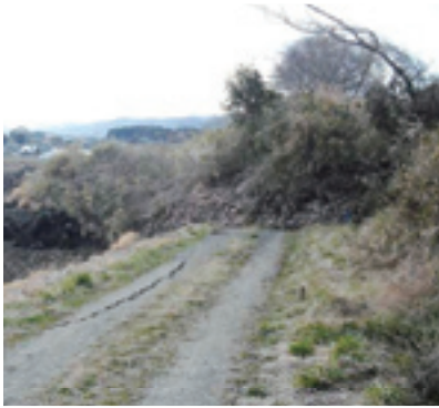
土砂崩れによる農道封鎖、 農地への流入(北茨城市)
