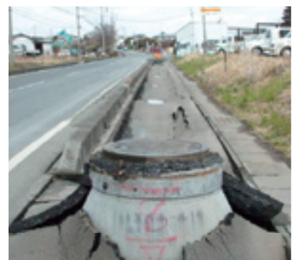
農業集落排水の マンホールの突出(那珂市)
