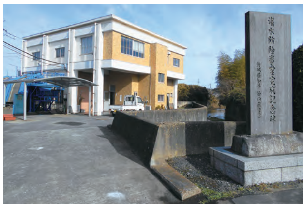
真崎浦排水機場
