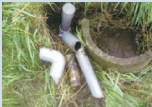
盗難被害に遭った給水用バルブ
