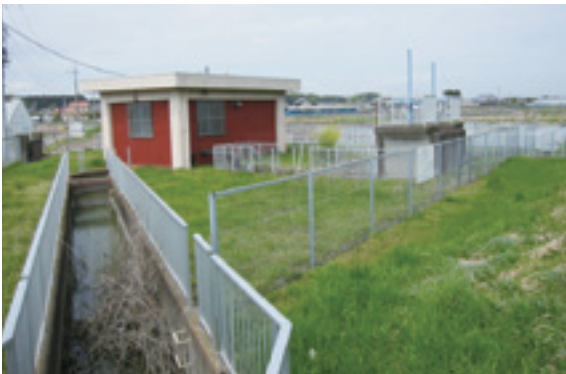
大井戸用排水機場
