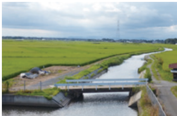
排水樋門から山川を望む
