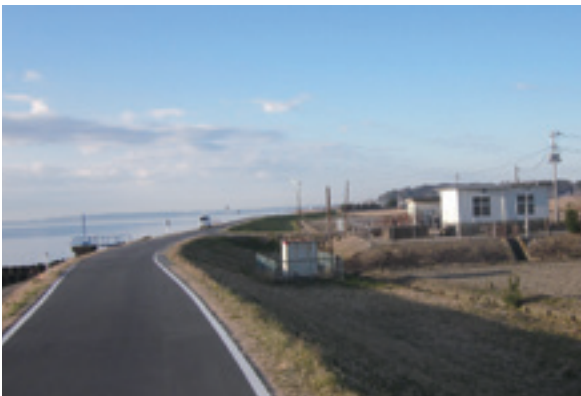
霞ヶ浦に隣接する用排水機場
