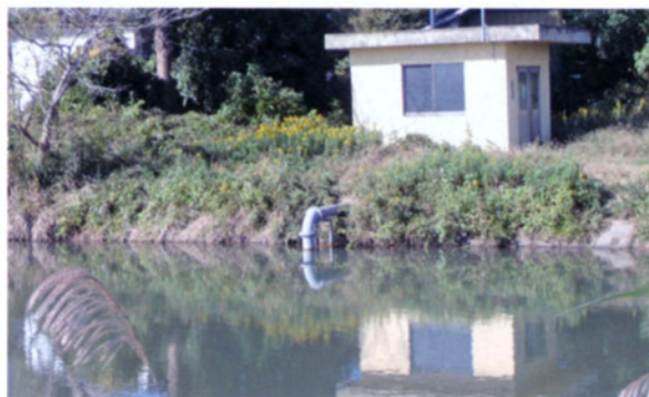
第4工区下池機場
