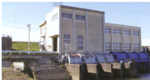
幹排機場及び湛水防除排水機場
