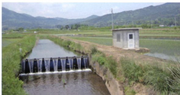
第1工区随光寺第2機場堰
