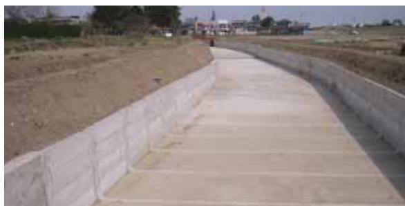
H17県単土地改良事業実施（八田地区） 排水路護岸工事
