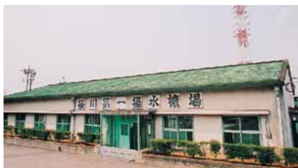
桜川第一揚水機場
