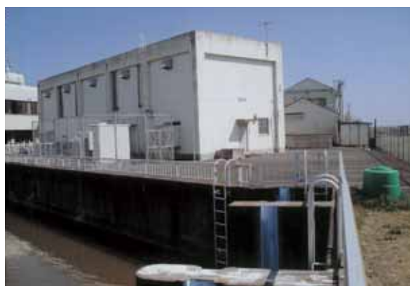
出島揚水機場
